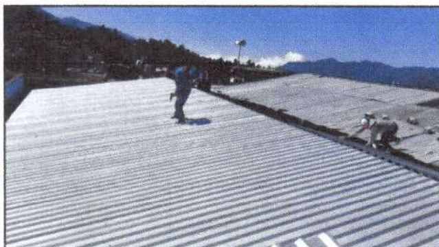
Foto 3: Sustrucción de capote de lámina para lámina troquelada
