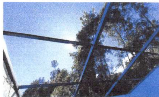
Foto 4: Sustrucción de soporte de madera por metal
