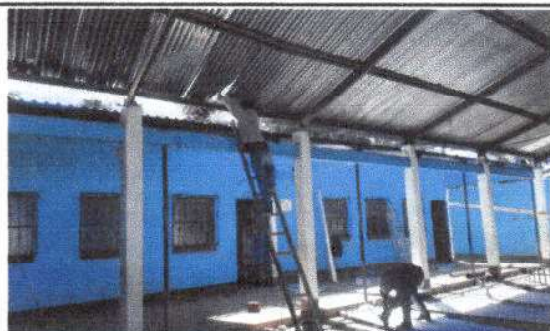
Foto 5: Sustrucción de canal de pvc
