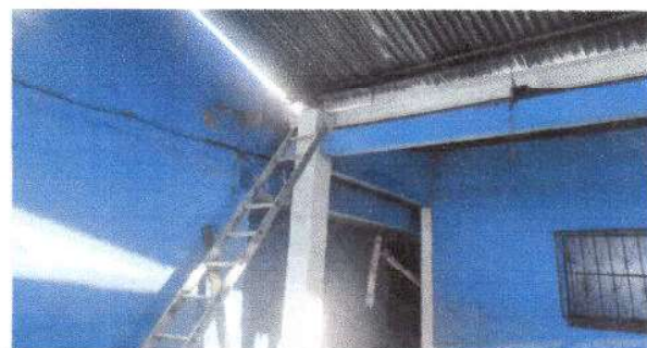
Foto 6: Sustrucción de soporte o pescante de metal para canal
